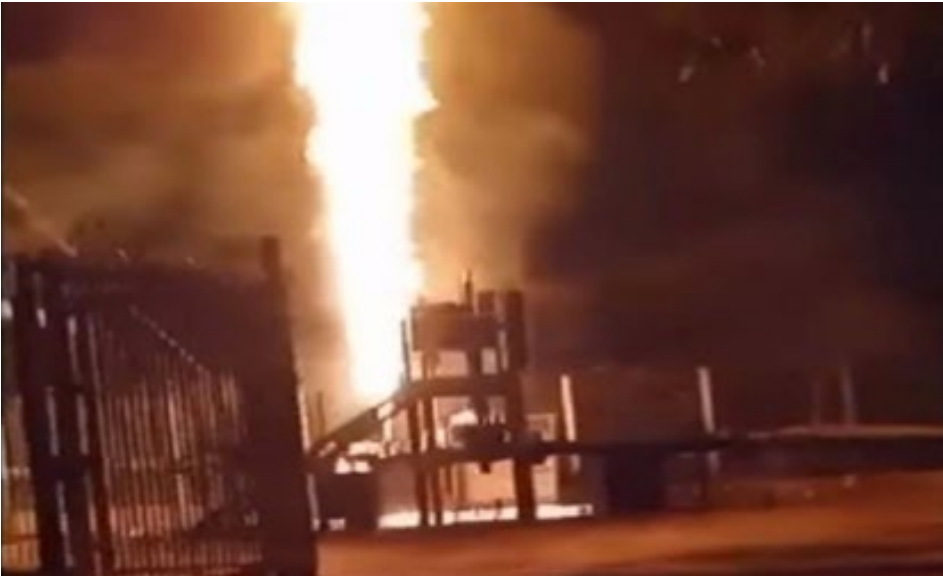
Explosión en Subestación de PDVSA en Yaracuy por extracción ilegal de combustible
