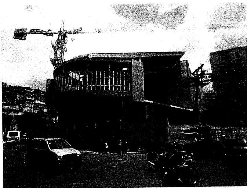
DSC00003 Estación Palo Verde III Vista Exterior
