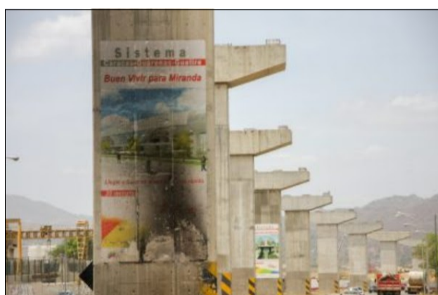
Retraso y sobrecosto acumulan 12 importantes obras del Ministerio de Transporte
