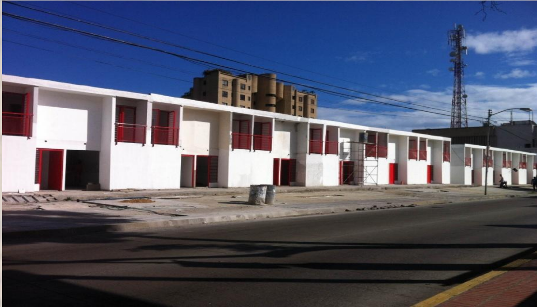
Urbanismo OPPPE 32, ubicado en la Av. La Playa, estado Vargas, ejecutado por la Oficina Presidencial de Planes y Proyectos Especiales (OPPPE) (19 de junio de 2014)
