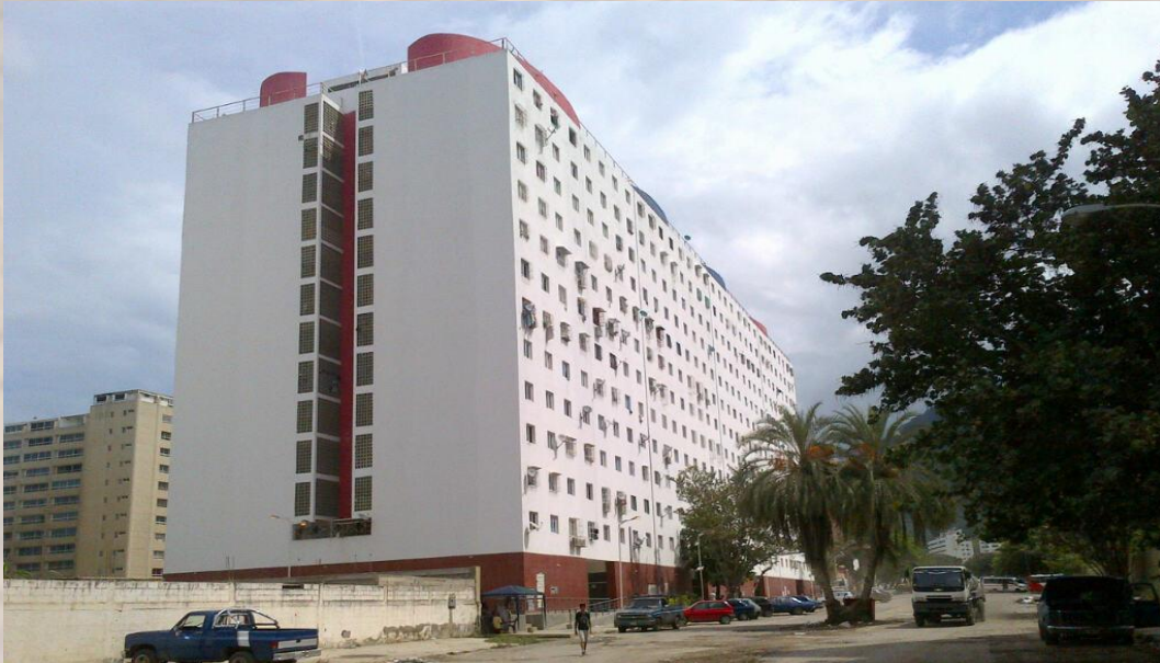
Urbanismo OPPPE 22-A, ubicado en la Av. Boulevard de Naiguatá, en el estado Vargas, ejecutado por la Oficina Presidencial de Planes y Proyectos Especiales (OPPPE) (13 de marzo de 2014)
