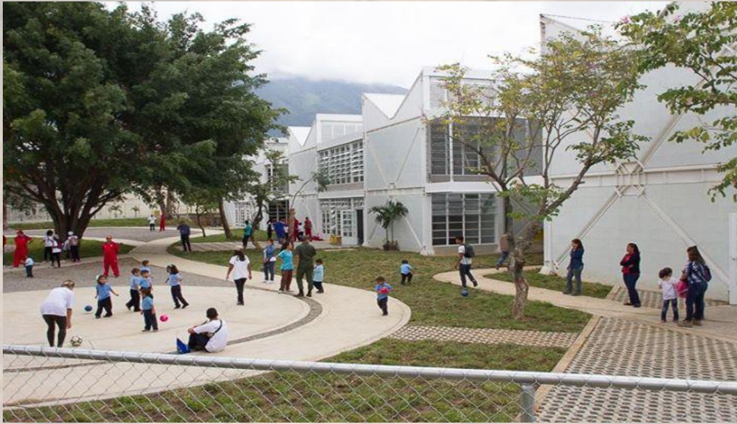
Entrega por parte de la OPPPE de la obra denominada: Unidad Educativa Nacional “Generalísimo Francisco de Miranda”, entre los ejes 6 y 8 del Parque Bolívar, municipio Chacao, estado Miranda (16 de septiembre de 2014)
