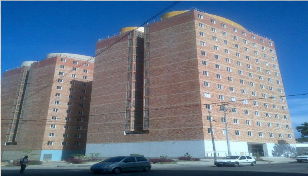
Urbanismo OPPPE 34, ubicado en la Av. Boulevard de Naiguatá en el estado Vargas, ejecutado por la Oficina Presidencial de Planes y Proyectos Especiales (OPPPE) (30 de abril de 2014)
