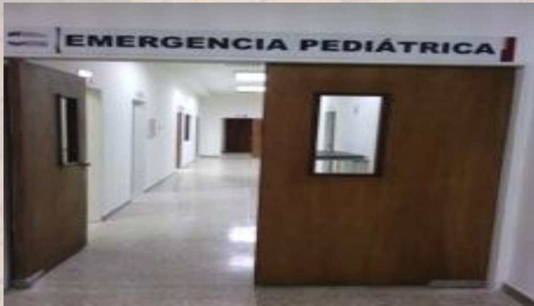
Culminación de la obra denominada: Arquitectura e Ingeniería, para consolidar el ambulatorio urbano III Etapa Plateja, municipio Maracaibo, estado Zulia, ejecutada por la Fundación Propatria 2000 (24 de octubre de 2014)
