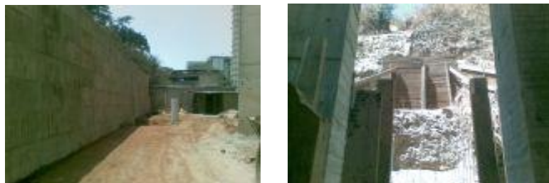
Ilustración 8. Estabilización de talud y construcción de torrentera en la parroquia Sucre.
