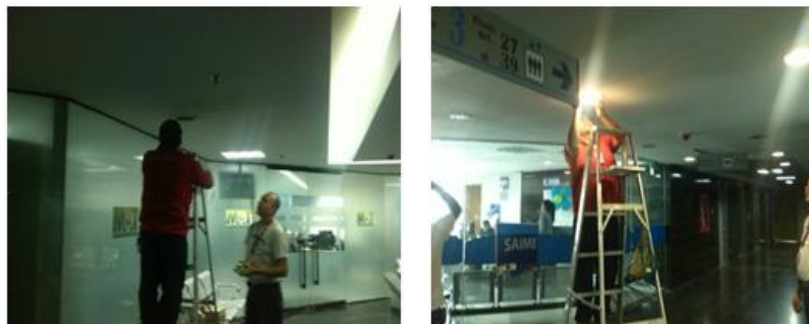
Ilustración 116. Suministro de instalación de materiales eléctricos para la plaza "Hugo Chávez"
