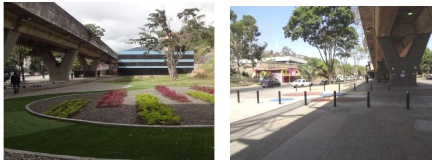
Ilustración 4. Rehabilitación de espacios públicos en la parroquia Caricuao.
