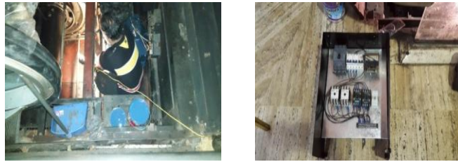
Ilustración 105. Suministro e instalación de escaleras y elementos de transmisión mecánica de la torre oeste.
