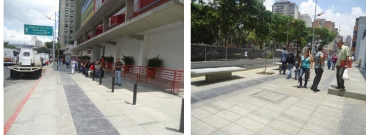
Ilustración 1. Rehabilitación de aceras e incorporación de mobiliario urbano.
