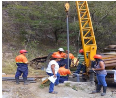
Ilustración 121. Sistema integral de utilización eficiente y recirculación de aguas para las plantas de arenado.
