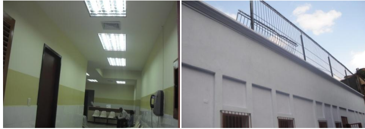
Ilustración 9. Rehabilitación de espacios internos del Ambulatorio Leonardo Ruiz Pineda, parroquia San Agustín.
