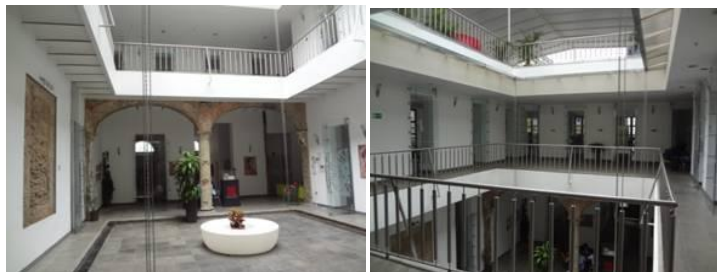
Ilustración 12. Rehabilitación de estructura arquitectónica del hotel León de Oro.
