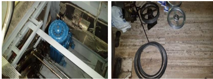
Ilustración 104. Actividades de mantenimiento preventivo y correctivo de la torre oeste.
