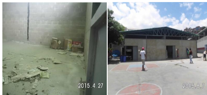
Ilustración 7. Adecuación de los galpones de la Ciudadela.
