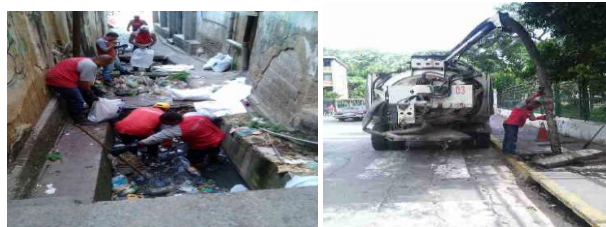
Ilustración 99. Limpieza y mantenimiento continuo de quebradas y torrenteras
