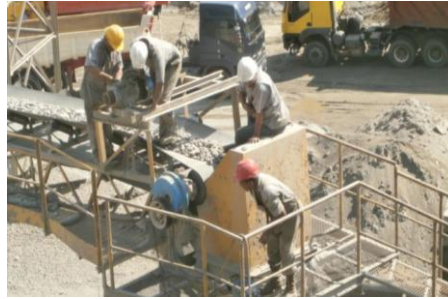
Ilustración 118. Operaciones preventivas de la Criba 6 perteneciente a la Planta Trituradora II.
