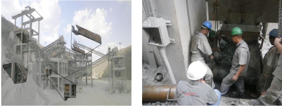
Ilustración 117. Ubicación de las principales piezas con fallas críticas en la planta II (P-II): Mandíbula principal del triturador; cono triturador N° 9 y Criba de selección N°15.
