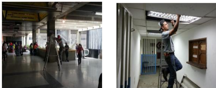
Ilustración 109. Reparación y mantenimiento general del sistema de iluminación de los edificios residenciales: Caroata, Tajamar, San Martín y el Tejar.
