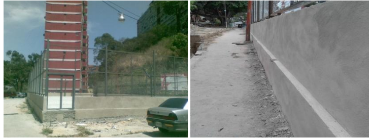
Ilustración 10. Construcción de losa y pared perimetral del bloque 09 de las Lomas de Urdaneta, parroquia Sucre.
