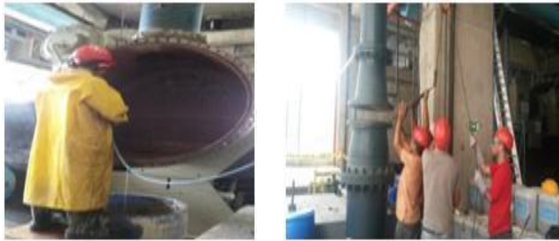
Ilustración 115. Mantenimiento preventivo y correctivo de los sistemas de agua potable, servidas y nivel freático.
