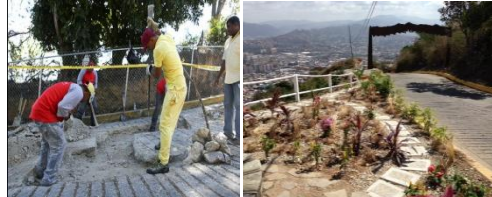
Ilustración 104. Rehabilitación integral del camino de los Españoles.
