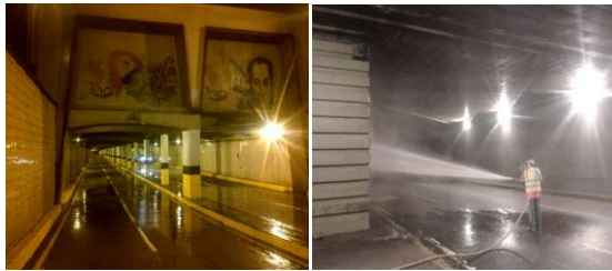
Ilustración 101. Reparación y mantenimiento de túneles.
