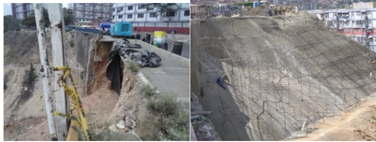
Ilustración 6. Movimiento de tierra y construcción de talud en la parroquia 23 de enero.
