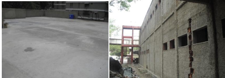
Ilustración 11. Picoteo y friso en áreas exteriores del Centro Diagnostico Integral.
