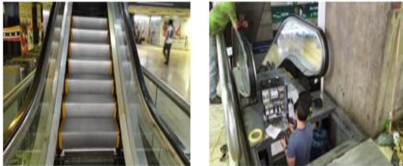
Ilustración 103. Mantenimiento preventivo y correctivo en la torre oeste del Complejo Urbanístico Parque Central.
