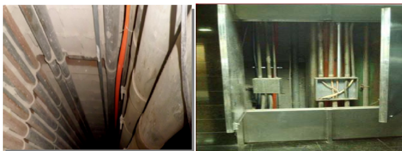
Ilustración 99. Sustitución y mejoramiento de tuberías de agua potable en la Torre Este del Complejo Urbanístico de Parque Central.
