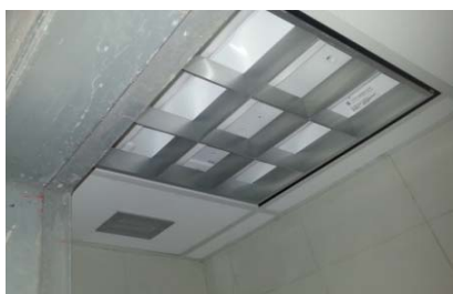
Ilustración 104. Sistema de ventilación forzada para ambientes sanitarios de la Torre Este del Complejo Urbanístico de Parque Central.
