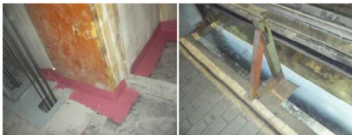
Ilustración 100. Instalación del Corta fuego en aberturas de bordes del piso 50 y de los edificios 1 y 2 de la Torre Este del Complejo Urbanístico de Parque Central.
