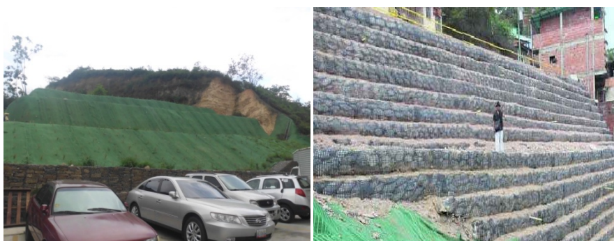
Ilustración 20. Atención a falla de borde en el CC2 de Caricuao.
