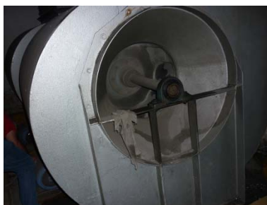
Ilustración 117. Mantenimiento de los sistemas de extracción de los sótanos del Complejo Urbanístico de Parque Central.
