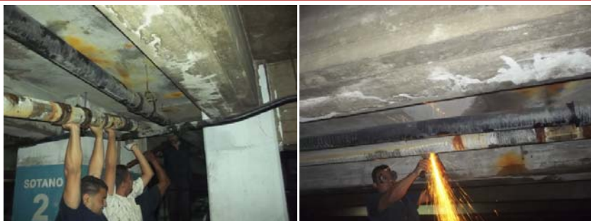
Ilustración 106. Desmantelamiento de tuberías en desuso de agua potable, servidas, pluviales e incendios de los pisos y ductos de la Torre Este del Complejo Urbanístico de Parque Central.
