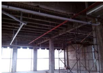
Ilustración 102. Construcción de drenajes para aguas pluviales, retícula de cristal del piso 52 de la Torre Este del Complejo Urbanístico de Parque Central.
