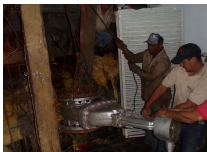
Ilustración 115. Recuperación e instalación de válvulas del sistema de distribución de agua potable.
