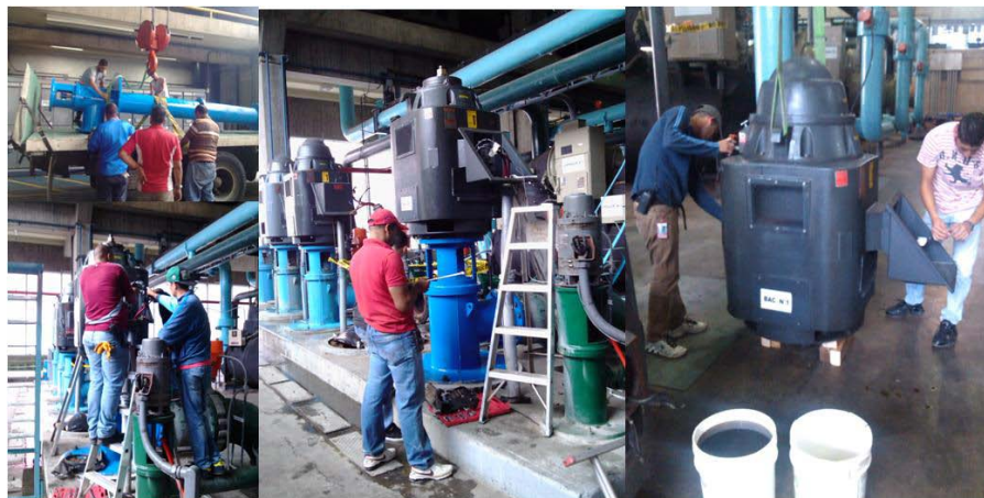
Ilustración 86. Mantenimiento e instalación de repuestos mayores para la planta de agua helada.
