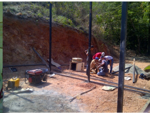
La Chispa – Construcción de Gallineros
