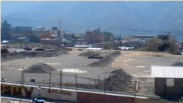
Obra paralizada en Mérida, Av. Las Américas
